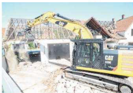
Ein Haus verschwindet: Stück für Stück nehmen Bagger den Altbau auseinander und schaffen so Platz für das künftige Gesundheitszentrum.
