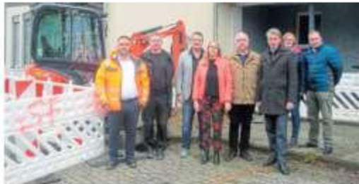
Gruppenbild am Bagger: Vertreter von Stadt und Schulen freuen sich über den Anschluss des Schulzentrums ans Glasfasernetz.
