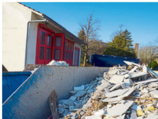
Die ersten Mulden mit Bauschutt sind schon voll. Die Ehrenamtlichen legen sich mächtig ins Zeug. Foto: Michael Nichau
