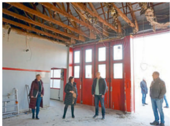
Die Zwischendecke ist schon raus. Jetzt soll der Dachstuhl gerichtet werden. Foto: Michael Nichau
