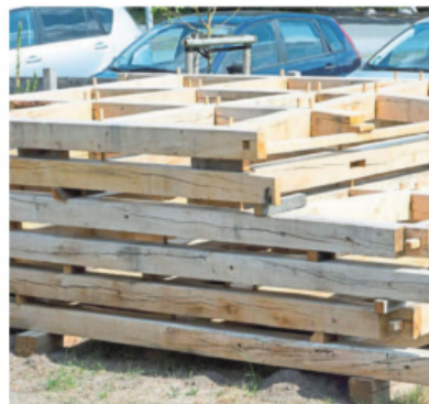
Die Eichen-Fachwerkwände liegen schon fertig verzimmert auf dem Mühlenlängende.
