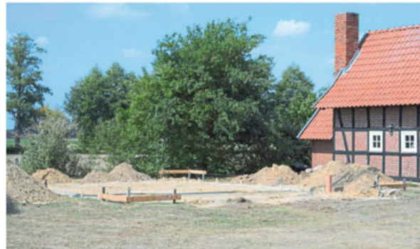
Auf der Baustelle in Wehe sind schon Fortschritte zu erkennen, es wurden bereits die Fundamente betonierte.
